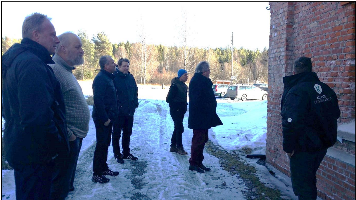
Museumshåndverker Morten Hjarnø forteller om forsøk med ulike fuger i murverket på industribygningen på Klevfos.
